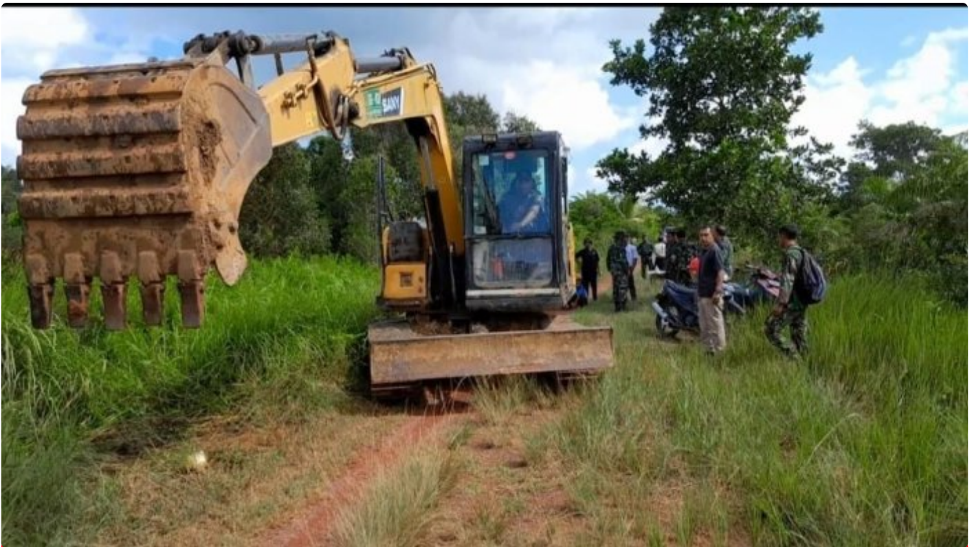
Dandim 1009/Tla, Turunkan Excavator Di Lokasi TMMD
