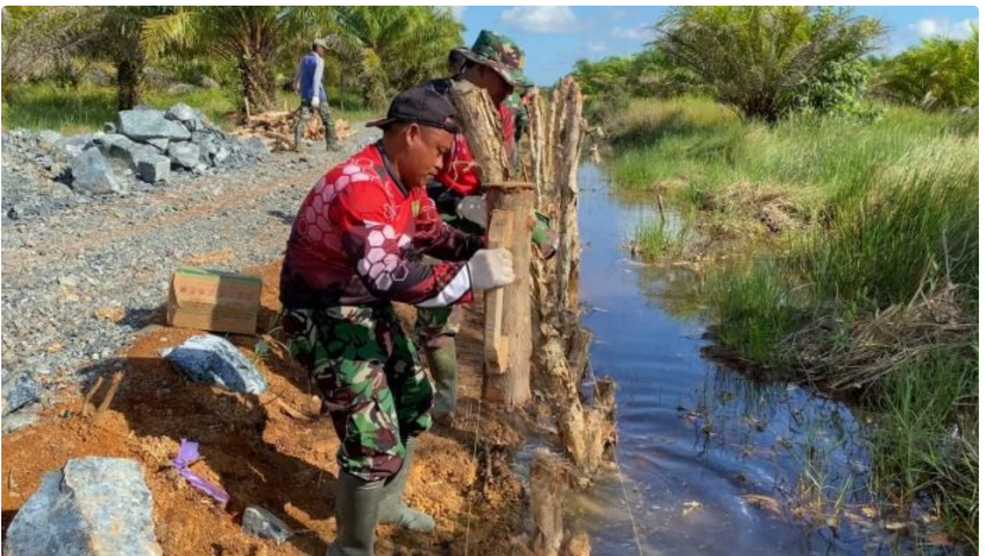
"Kayu Galam" Potensial Untuk Landasan Pemasangan Pondasi
