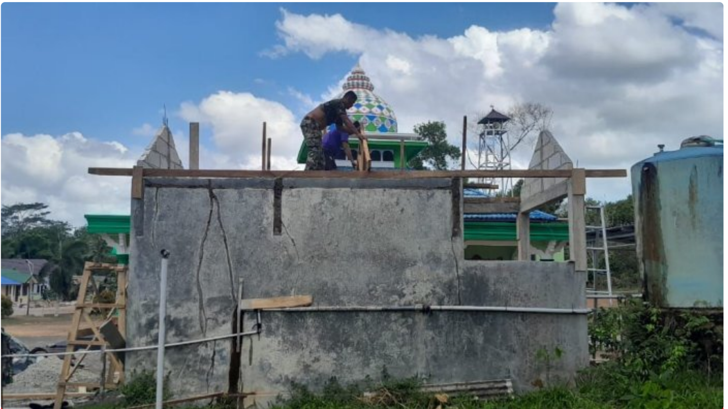
Masjid Rampung, Tempat Wudhu Dan MCK Masjid Al Mujahidin Dikebut Satgas TMMD
