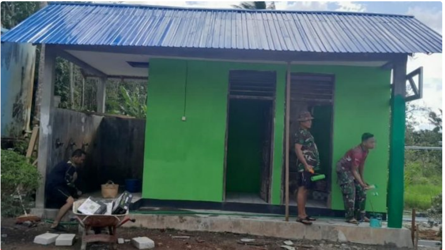
Pengerjaan Sasaran Rehab Masjid, Tinggal Finising
