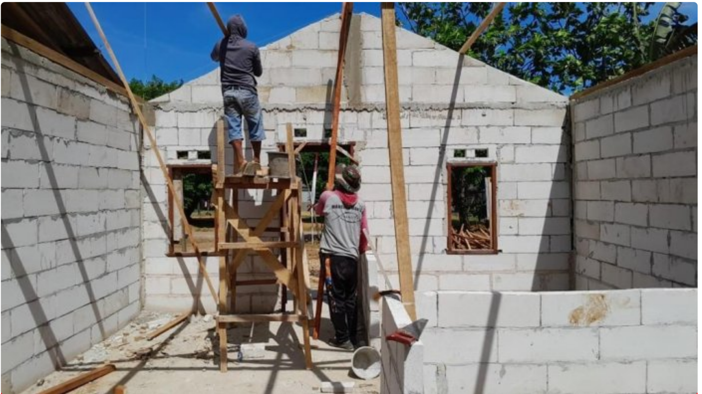
Rasa Haru Mbah Sandi Melihat Dinding Rumahnya Sudah Berdiri
