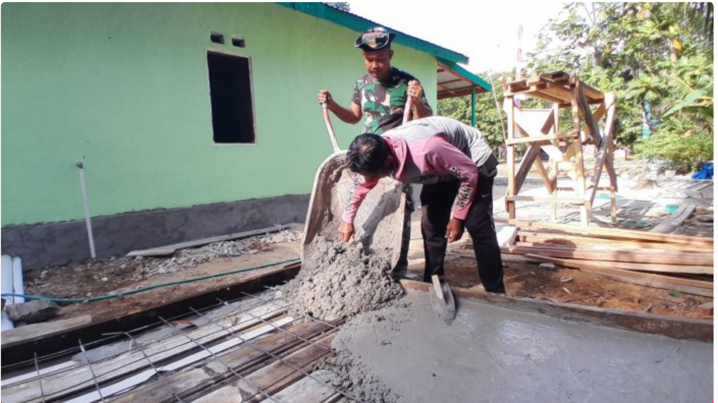
Rumah Mbah Sandi, Dilengkapi MCK Sesuai Standar Kesehatan
