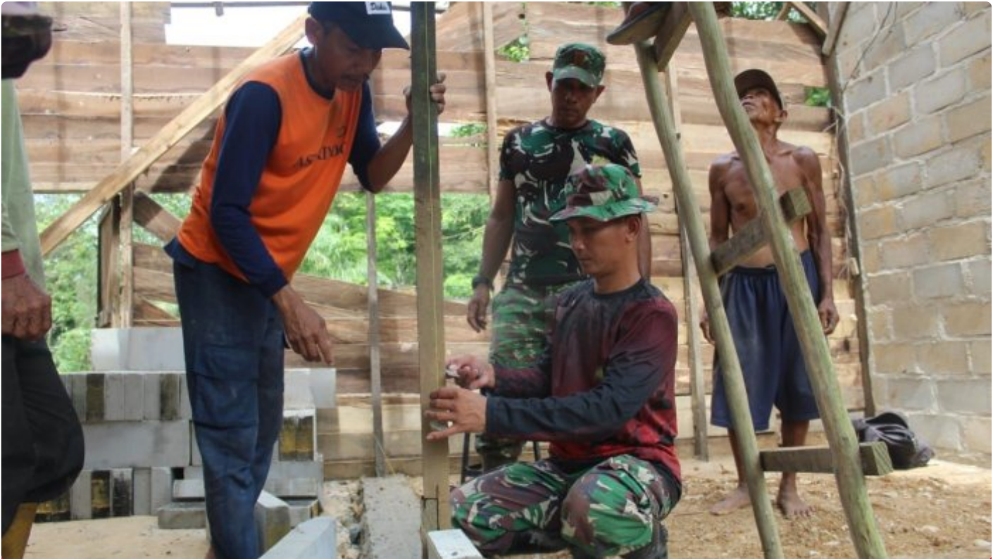
Sasaran Bedah Rumah, Sudah Tahap Pemasangan Dinding
